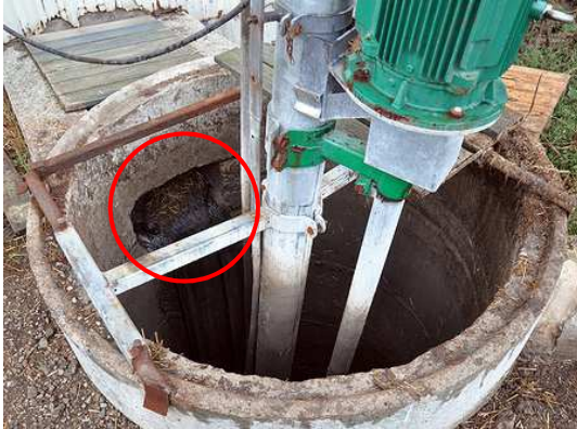
Gödselgasventilation saknas.
