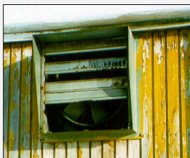
Trasigt och fastrostat jalusispjäll
