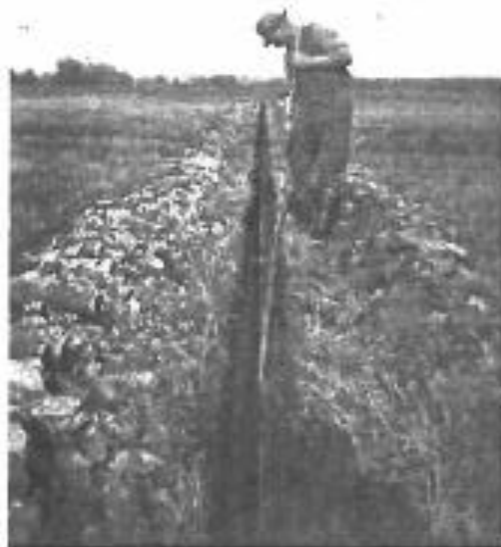
Fig. 141. Läggning av ränn.
