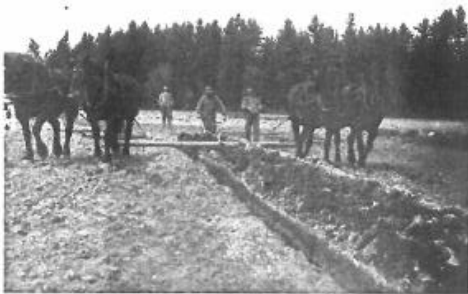
Fig. 130. Återfyllning av tieldiken genom plöjning.
