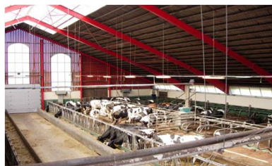
Helt golv med lutning mot mitten Skrapor till tvärkulvert
