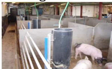
Delvis spaltgolv, 40% Skrapor under spalt
