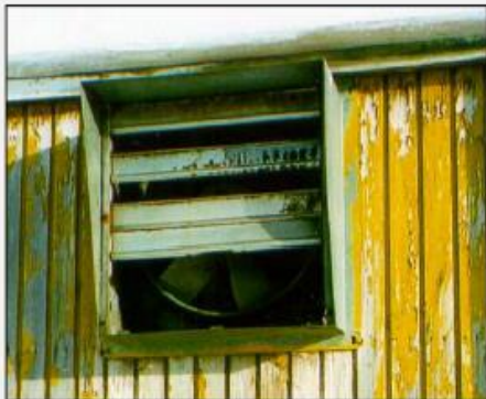
Trasigt och fastrostat jalousispjäll
