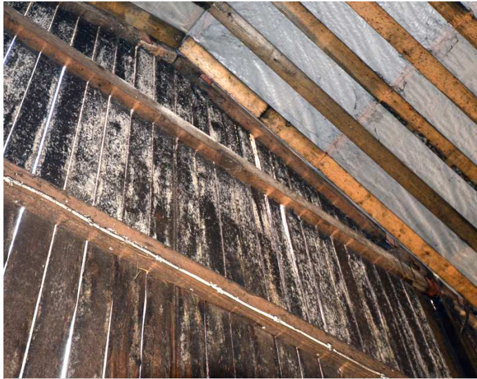
Häststall. Tagit bort innertak för att få "naturlig ventilation"
