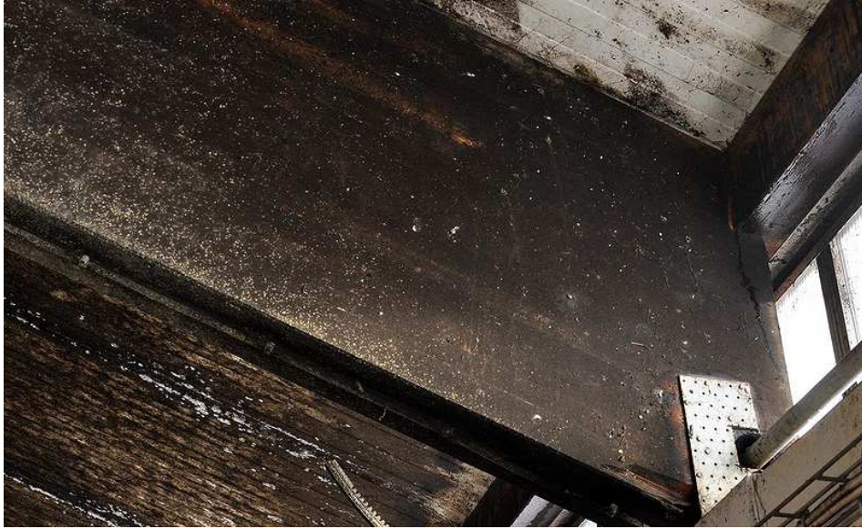
Effekten av för liten minventilation i 6 år gammal lösdriфт
