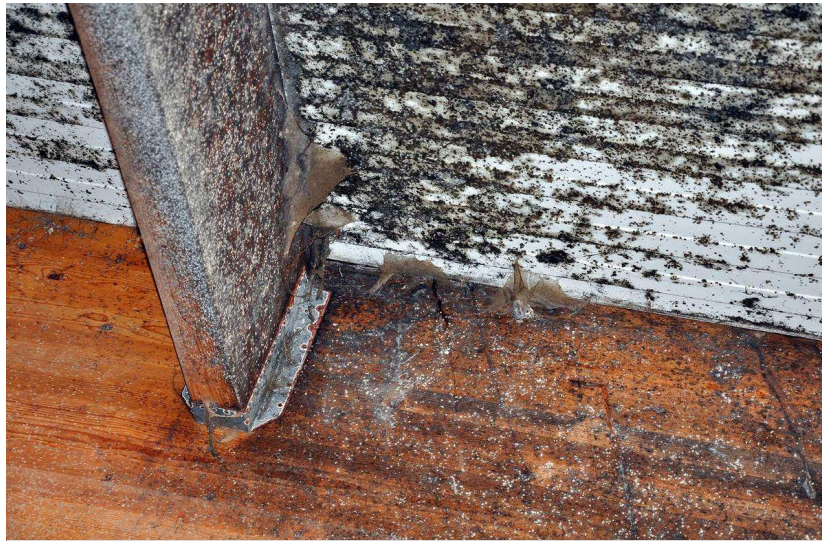
Effekten av för liten minventilation i 6 år gammal lösdraft
