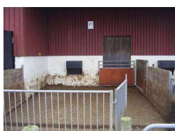
Rastgård av betong
