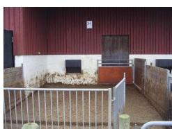
Rastgård av betong
