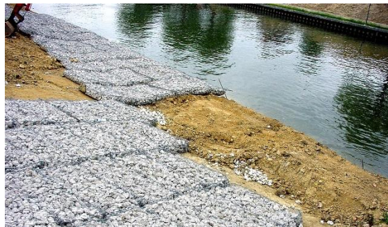
Bild 4: Gabioner i åslänt (Lamiot 2001)
