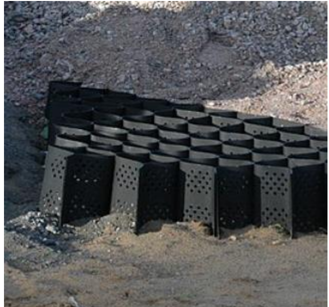
Bild 2: Geocell vid vägkonstruktion (Drozdewski 2009)
