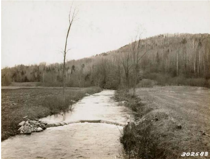
Bild 5: Cross vane gjord av trä i ett större dike (Carter 1935)
