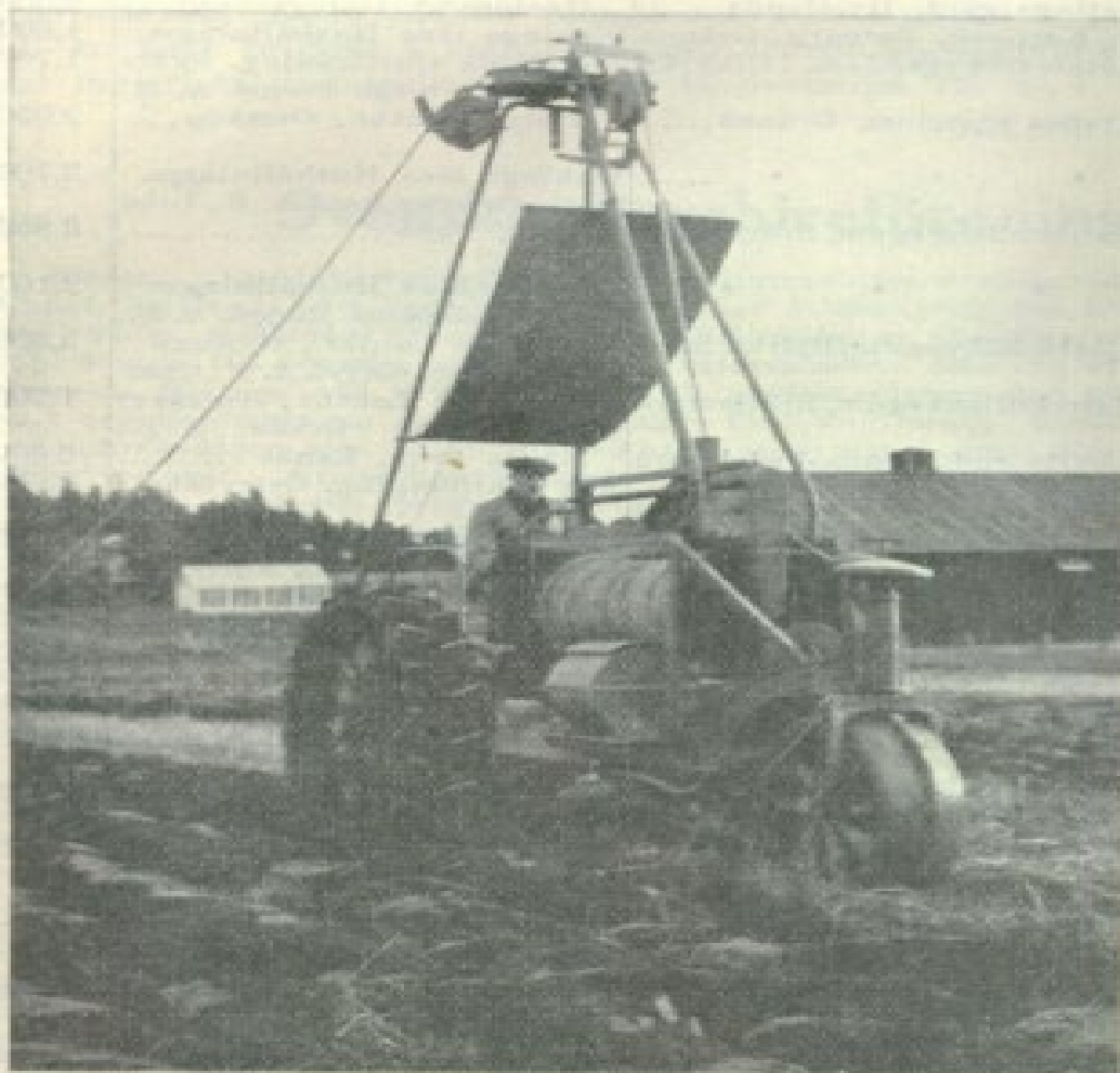
Fig. 1. Plöjning vid Ultuna hösten 1923. (Obs. Den elektriska motorn är monterad å en vanlig June-plog.)
