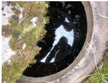
Bild 3. Kontrollera att brunnslöcket är tätslutande och att ventilationsröret är utformat så att regn och snö inte kan tränga in. Fogarna mellan cementringarna ska vara täta så att inte yttligt grundvatten eller vatten från markytan tränger in och förorenar brunnen.
