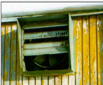
Trasigt och fastrostat jalousispjäll
