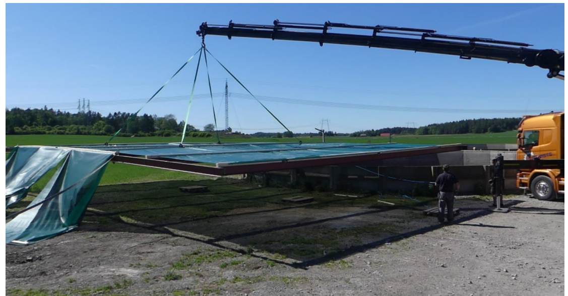
Nedsänkning av tak på behållare
